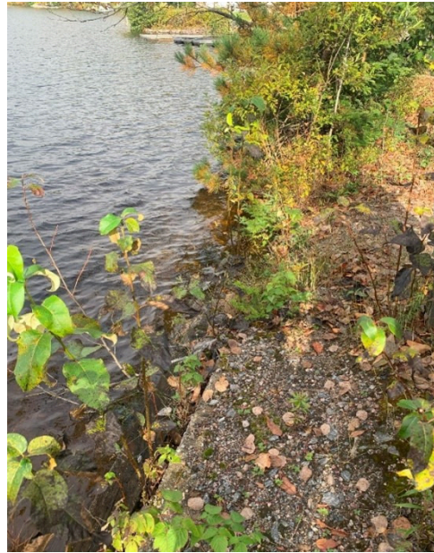
Figure 4-2 : Pente amont côté gauche. Muret de béton, zone d'érosion et zone végétalisée
