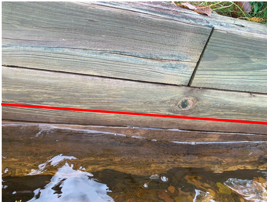
Figure 7-12 : LL sur la face amont du barrage – 297,56 m
