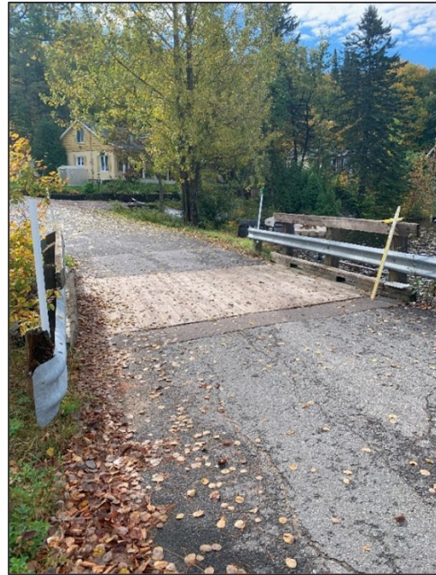
Figure 2-4 : Vue de la crête du barrage X0001518
