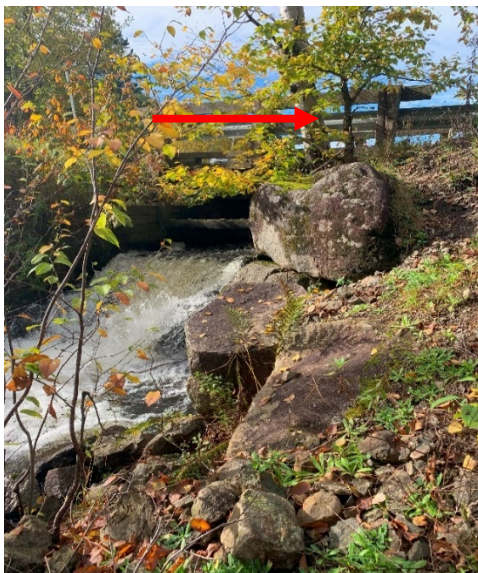
Figure 4-6 : Arbre du côté gauche de la structure, à l'aval du barrage
