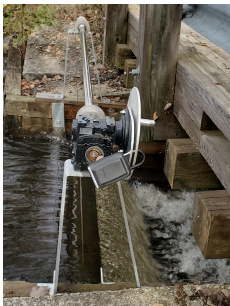
Figure 2-1 : Vue du barrage X0001518
