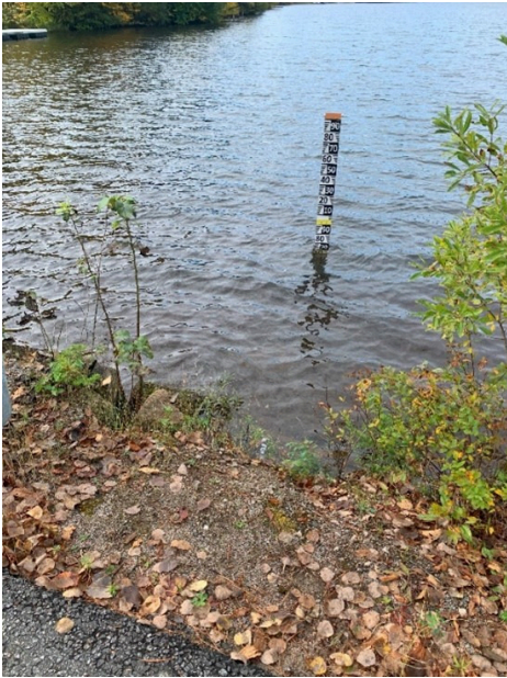
Figure 4-1 : Pente amont avec des signes d'érosion, rive gauche du barrage
