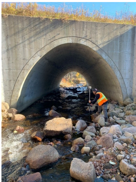
Figure 7-9 : Amont ponceau au PK 3+ 375
