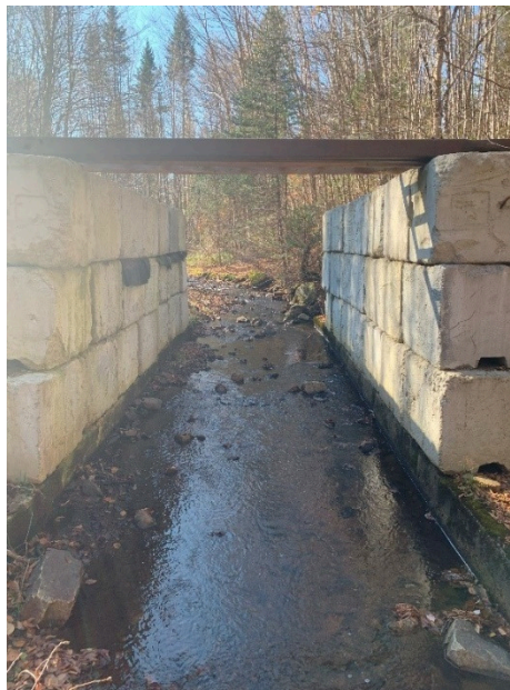
Figure 7-2 : Structure en bloc de pierre PK 0+150m
