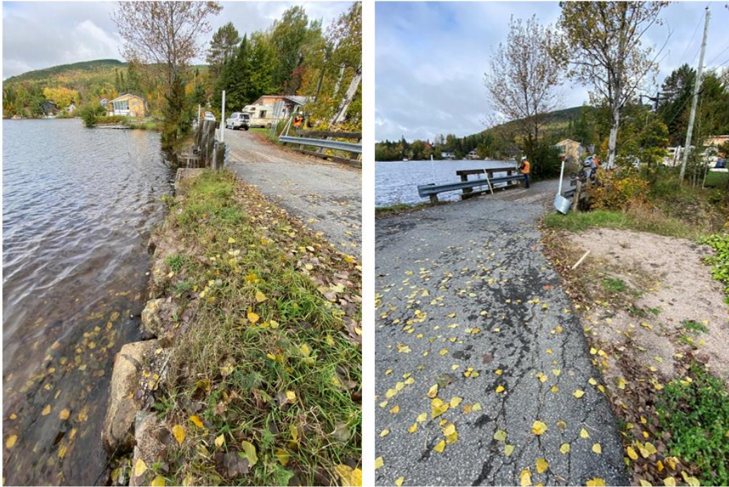
Figure 2 : Le chemin du Barrage, le lac à l'amont et l'accotement aval du barrage. Présence d'arbres sur les talus amont et aval. Vue de l'écoulement du lac vers le barrage et son déversoir intégré.
