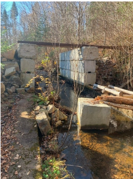
Figure 7-1 : Structure en bloc de pierre PK 0+150m
