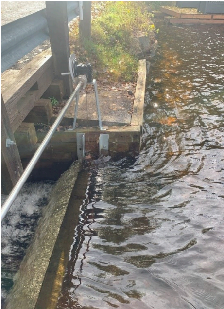
Figure 4-3 : Pente amont côté droit. Muret de béton et partie protégée par des pierres empilées
