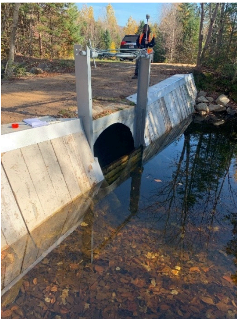
Figure 7-5 : Amont ponceau au PK 2+450
