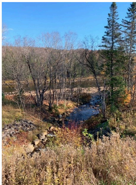
Figure 7-10 : Amont ponceau au PK 3+375
