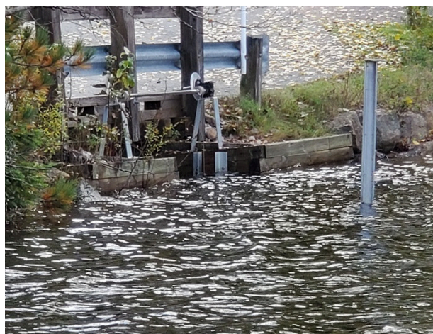
Figure 2-2 : Vue amont du barrage X0001518
